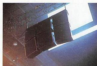
◀PA席の真上に設置されていたS-4システムのデイライ・スピーカー。6本のモノラル仕様になっている
